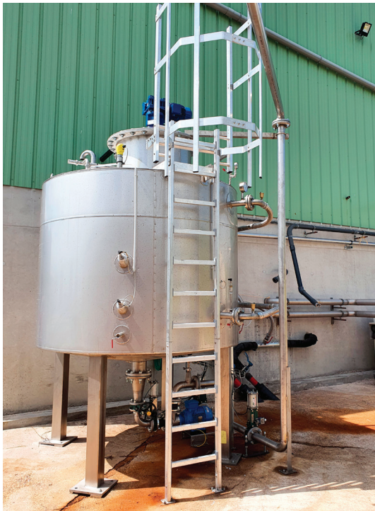
Unité d'hygiénisation des digestats de méthanisation Localisation : Grand-Est
